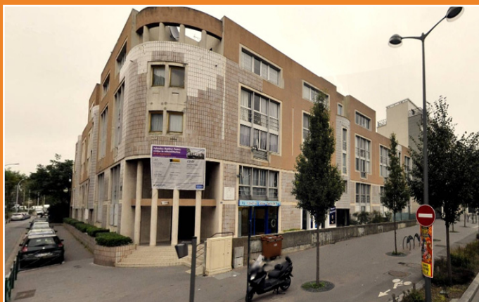
Travaux de réhabilitation au 176 bld Charles de Gaulle à Colombes (OPI)
