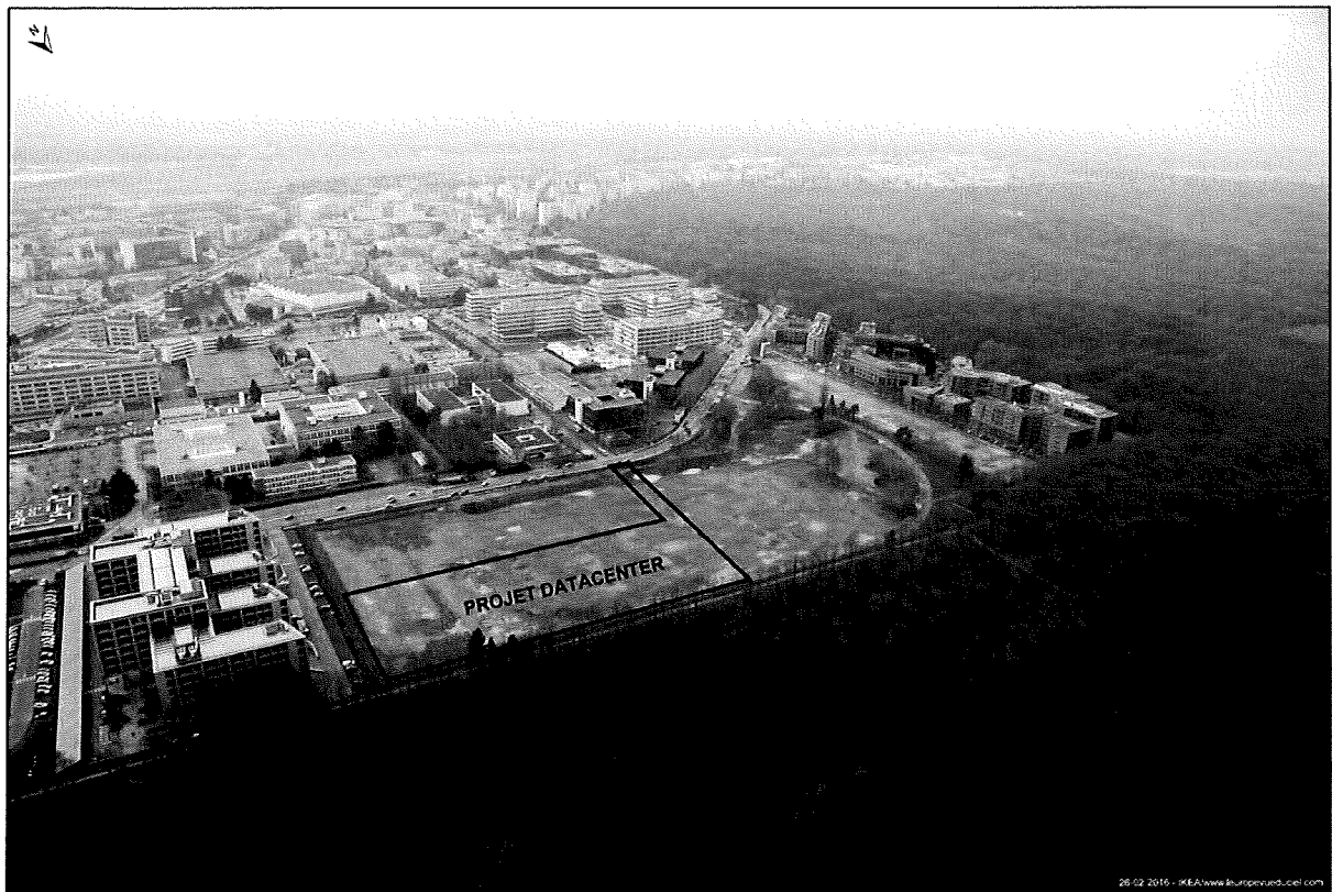
Vue aérienne de l'emprise du site
