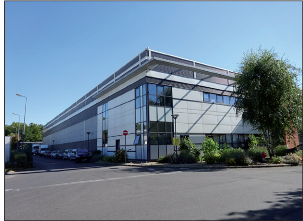
Extrémité nord-ouest du bâtiment A
