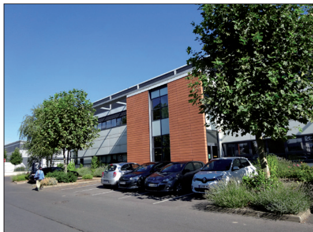
Entrée sur la façade ouest
