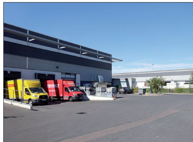
Zone de déchargement sur la façade est
