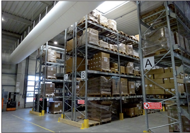
Regroupement du stockage dans une zone proche du mur CF 1h qui sépare l'atelier de l'entreprise voisine.
