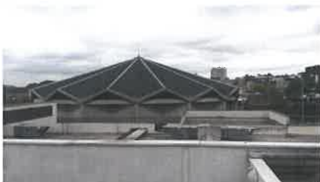
Vue depuis le bâtiment (logement 13)
