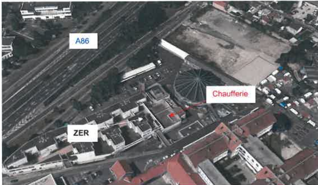
Vue sur les environs de la chaufferie
