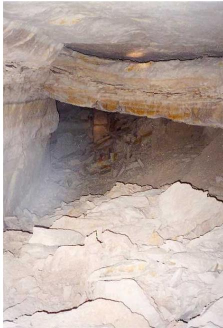
Figure 6 : Fatigue d'une galerie en front de taille
