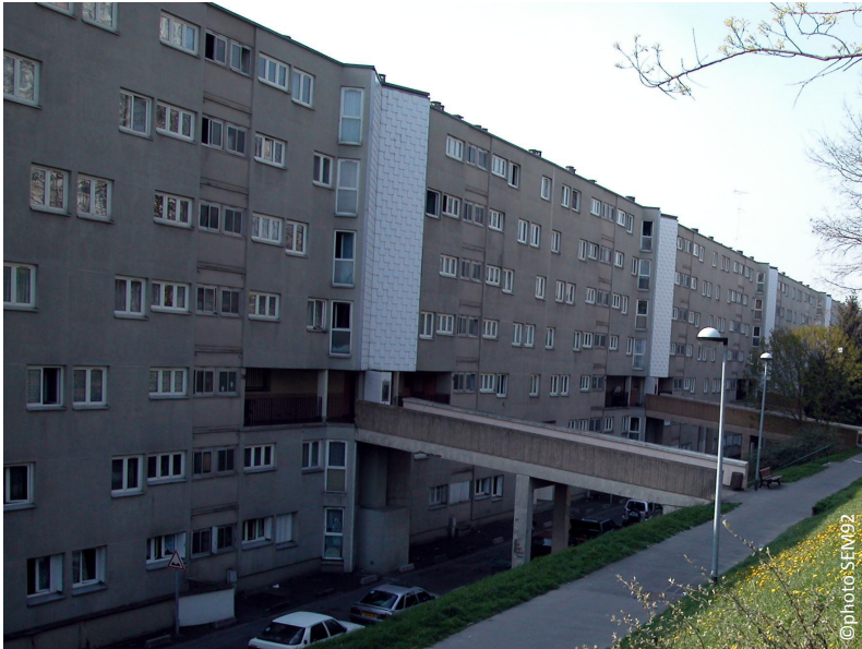
Bagneux : résidence "barre des Cuverons" avant réhabilitation
