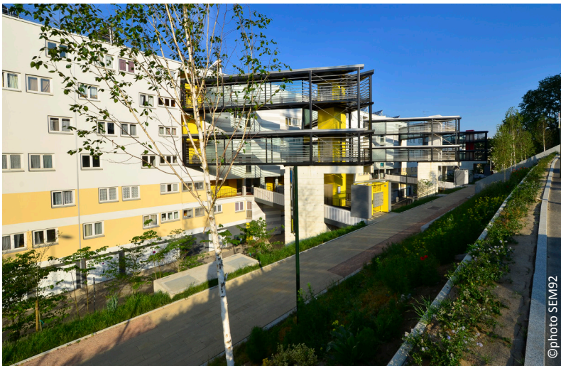
Bagneux : résidence "barre des Cuverons" après réhabilitation
