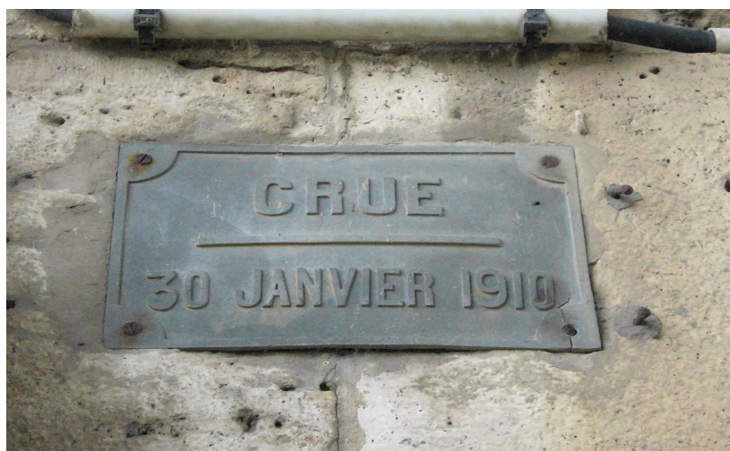
Fig 24 : Repère de crue à Rueil-Malmaison
