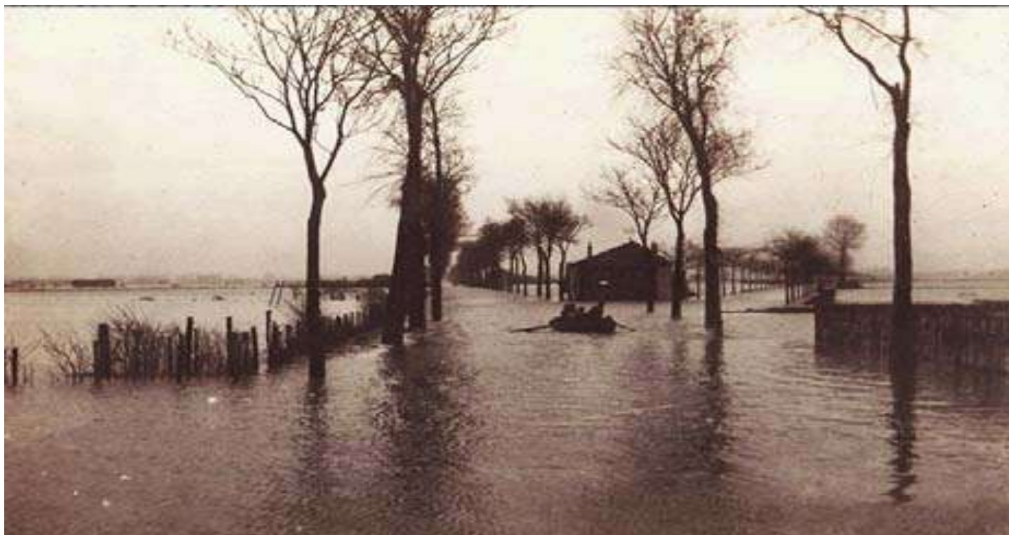
Fig 17: Crue de la Seine de 1910 : Avenue du pont Saint-Denis à Gennevilliers (source : DRIEAT IF, 2011)
