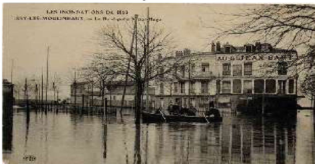
Fig 11: La crue de la Seine de 1910 à Issy-les-Moulineaux, source : EPRI/DRIEAT IF, 2011
